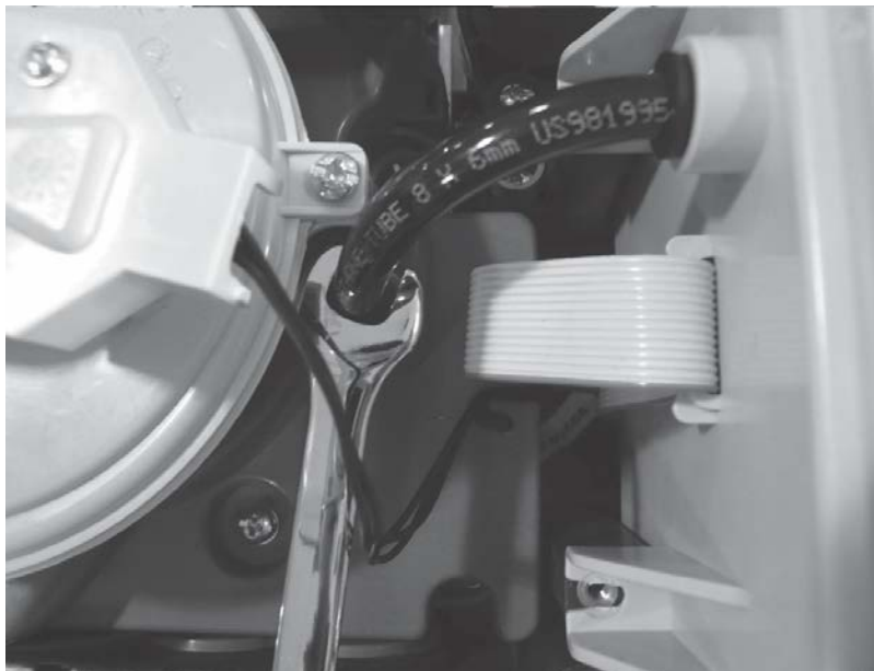
Abbildung 7-10: Kurzen Schlauch abziehen
